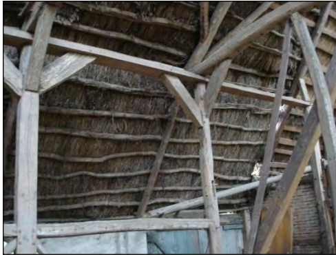
Innenansicht des Gebälks mit gewachsenen Dachstangen; Reetdeckung in Weidenbinde-technik
