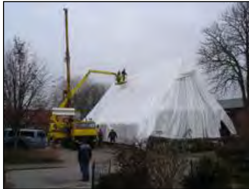
Die Alte Kate wird abgedeckt. Dezember 2007
